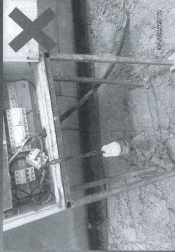
ตู้ไฟฟ้า Panel ที่ไม่ได้มาตรฐานถูกนำมาใช้งาน
