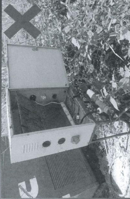
ตู้ไฟฟ้า Panel ที่ไม่ได้มาตรฐานถูกนำมาใช้งาน
